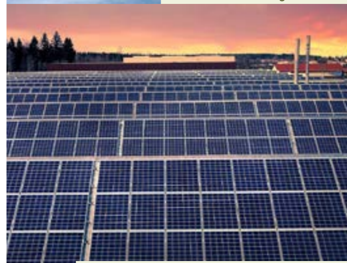
Centrale Photovoltaïque en toiture
