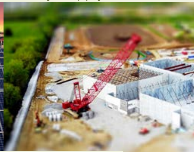
Chantier faibles nuisances
