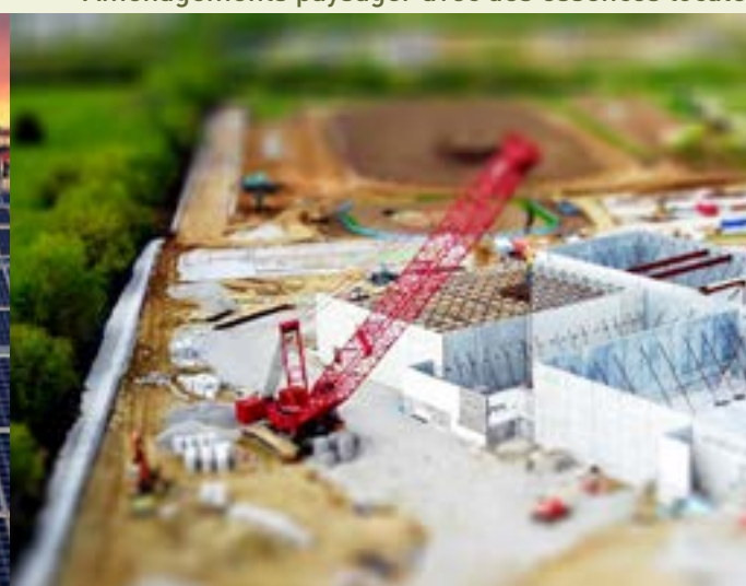
Chantier faibles nuisances
