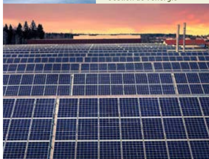
Centrale Photovoltaïque en toiture
